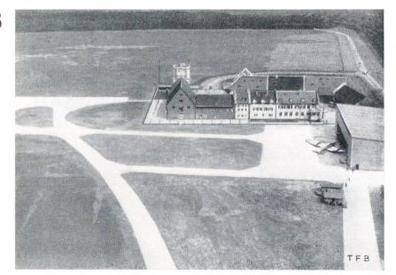
Pistes de décollage et d'atterrissage à l'aéroport de Francfort sur le Main. Plaques de béton posées sur lit de béton, superficie environ 10'000 m².
