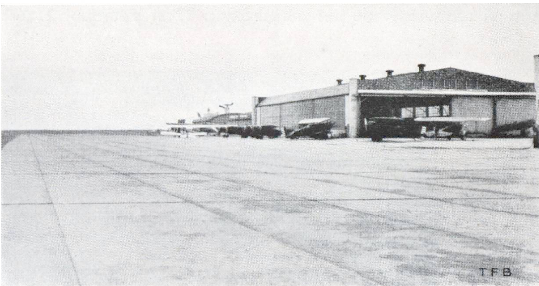
Fig. 11 La vaste surface de roulement en béton devant les hangars de l'aérodrome de Buffalo, U.S.A.
