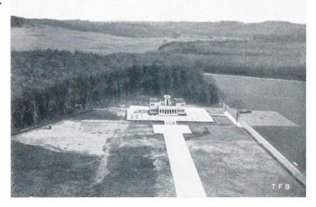
Piste de start de l'aérodrome de Giessen, longueur 200 m., largeur 10 m., avec plaques de béton posées sur lit de béton
