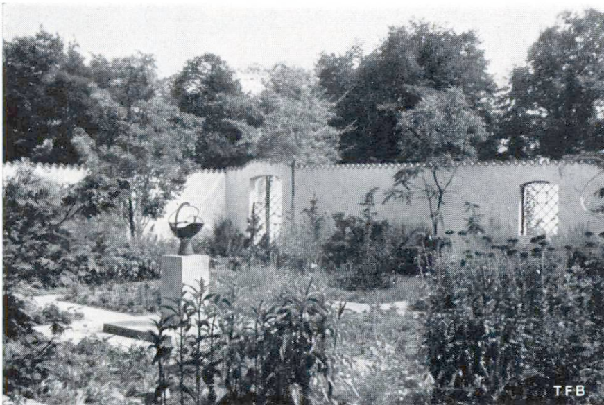
Fig. 7 Haut mur de clôture de jardin dans une propriété de maître Le faite est recouvert de tuiles pour éviter la pénétration de l'eau
