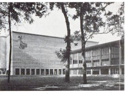
Nouvelle bibliothèque à Lugano 1940/41. Construction monolithique en béton armé avec façades brutes. C. et R. Tami, architectes SIA., Lugano.
