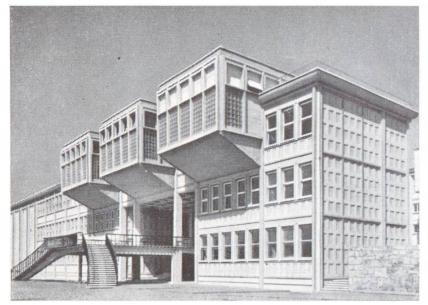
Nouvelle Université de Fribourg 1939-41. Construction monolithique en béton armé avec surface intérieure et extérieure étagée. F. Dumas et D. Honegger, architectes, à Fribourg. Beda Hefti, ing.
