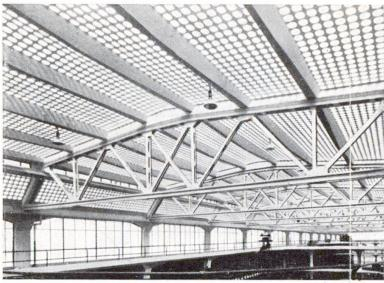
Toit de halle, fabrique chimique à Beeston (Agl. 0-32. Façonnage organique des nervures de plancher. Sir E. Owen Williams, architecte et ingénieur, Londres.
