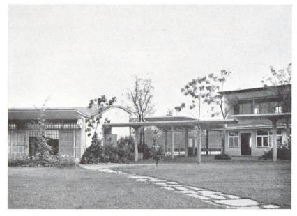
Entrée des bains à ciel ouvert Allenmoos, Zurich 1938-40. Toits protecteurs isolés, construction à champignons. A gauche halle du vestiaire avec toit élancé en béton armé. M. E. Haefeli et W. M. Moser, architectes FAS., Zurich. E. Rathgeb, ing. SIA., Zurich.
