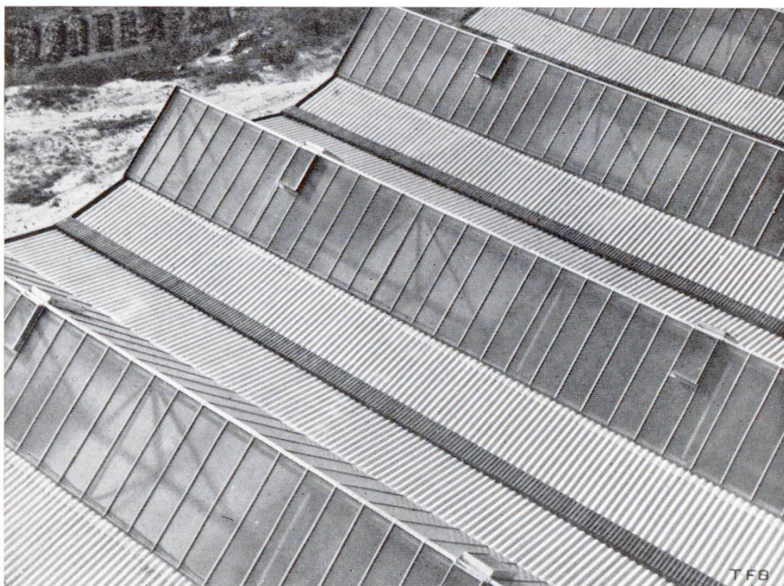
Fig. 6 Couverture d'une halle en Eternit ondulé et en verre.
