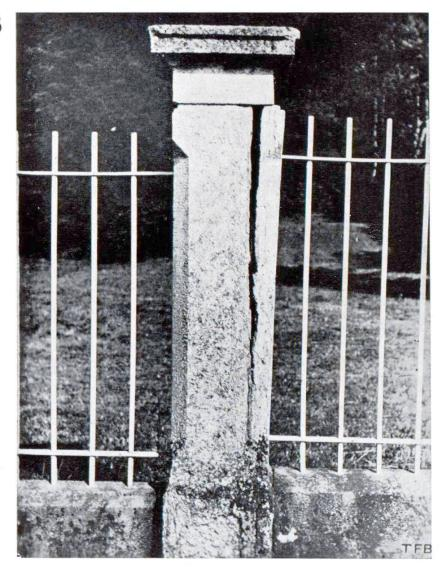
Fig. 2 Pilier en pierre naturelle fendu le long de la stratification par suite du raccourcissement, dû à la température, de la clôture en fer.
