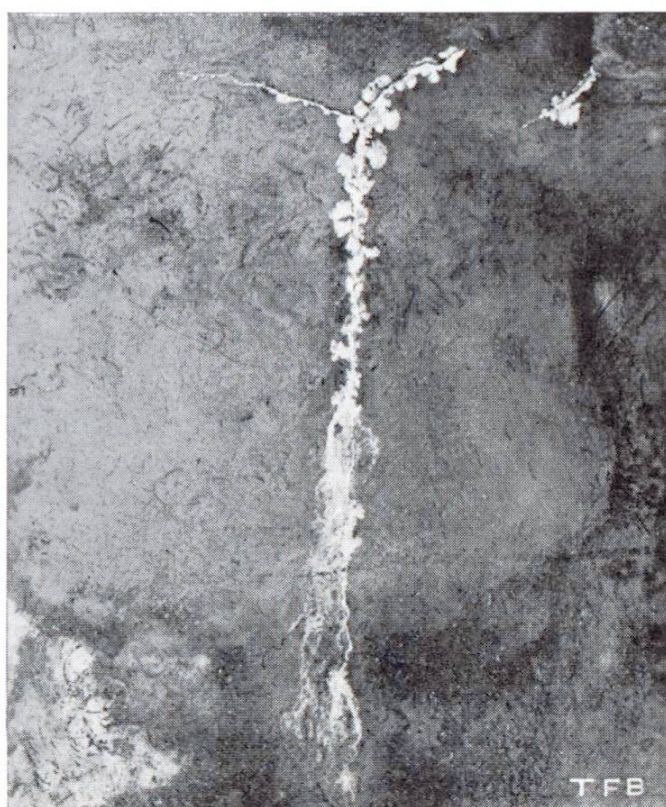
Fig. 2 Fissures d'affaissement dans les parois latérales d'un passage sous-voie. Après un certain temps, étanchement ou «guérison automatique» par colmatage.
