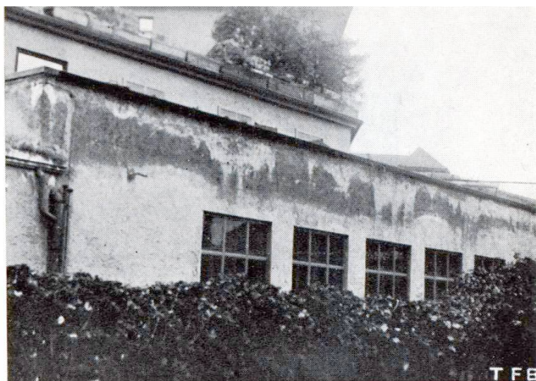
Fig. 1 Lorsque l'isolation est insuffisante, les balcons en forme de baignoire et les parapets de terrasses à ciel ouvert sont très exposés au danger des efflorescences et des taches.
