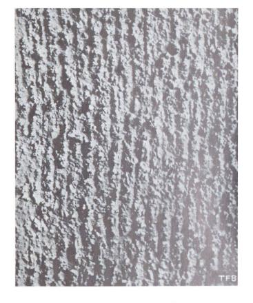
de gâcher le mortier d'une manière insuffisante et de l'appliquer trop vite, car souvent des petits grumeaux de chaux ne sont pas mouillés tout de suite et provoquent plus tard des écaillements résultant de leur expansion (extinction de la chaux vive). De tels écaillements sont toujours les conséquences d'un gâchage insuffisant et d'une mise en œuvre trop hâtive.
