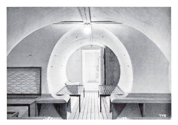
Fig. 6 Abri construit en tuyaux de béton centrifugé.
