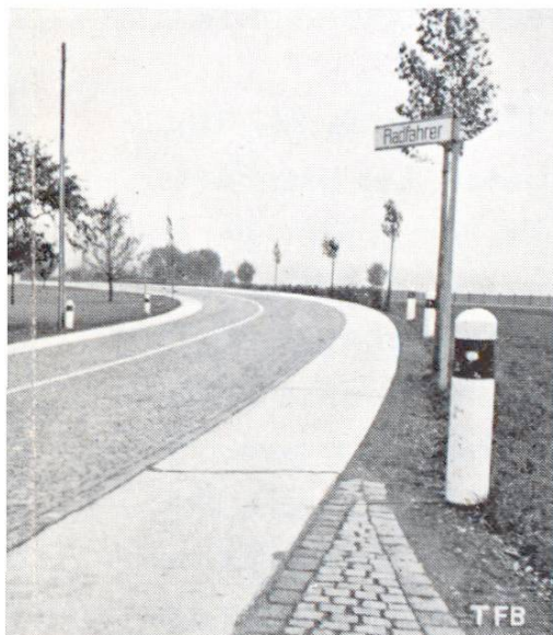
en béton Staad-Bauriet (St-Gall).
