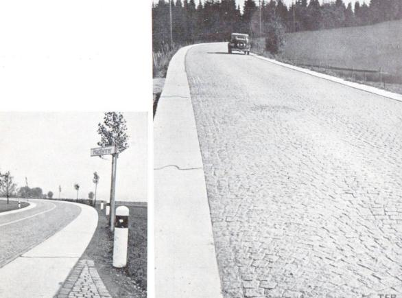
Fig. 3. Piste cyclable en béton (Norvège).
