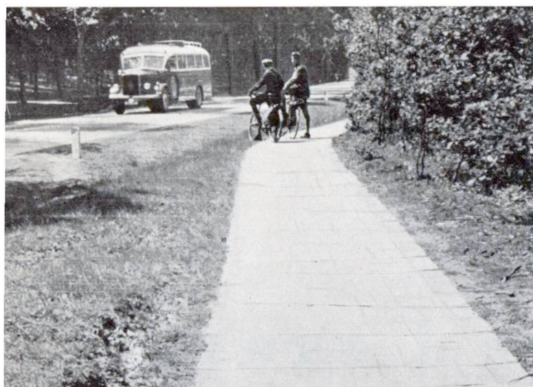
Fig. 1. Trottoir cyclable hollandais, construit à l'aide de carreaux en ciment.
