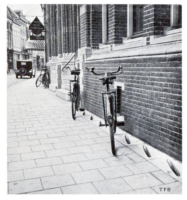
Fig. 7. Plaques en béton pour le stationnement des vélos.
