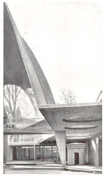
Fig. 2. Un des appuis jumelés de la halle du ciment.
