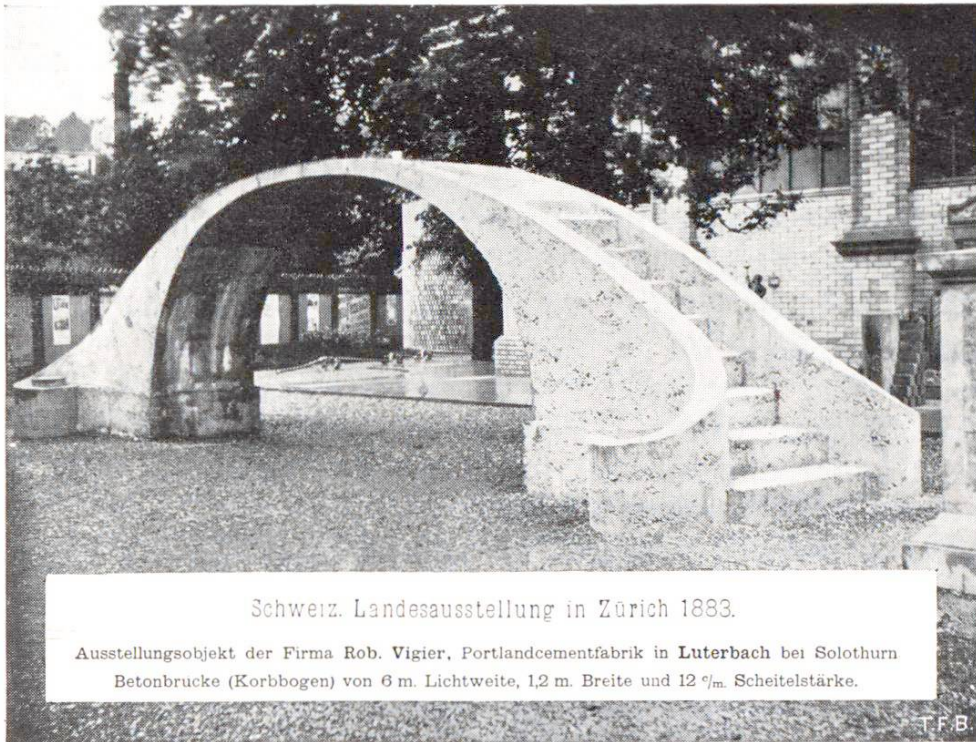
Fig. 4. Pont en béton à l'Exposition Nationale de 1883, présenté alors comme chef-d'œuvre de la technique du ciment et du béton.
