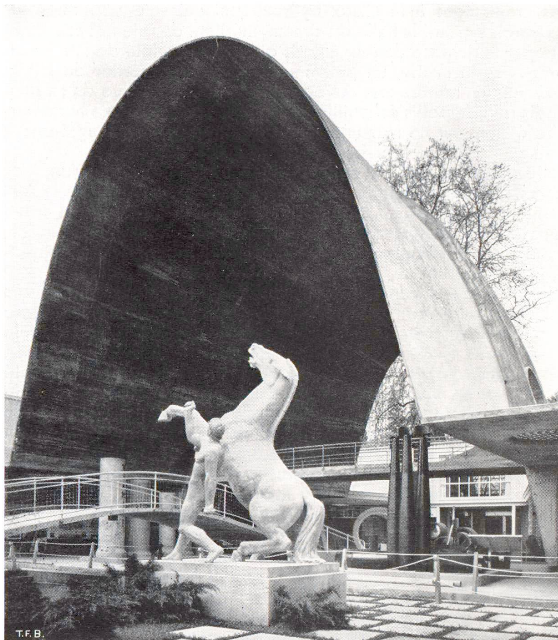
Fig. 5. Halle du ciment à l'Exposition Nationale 1939.
