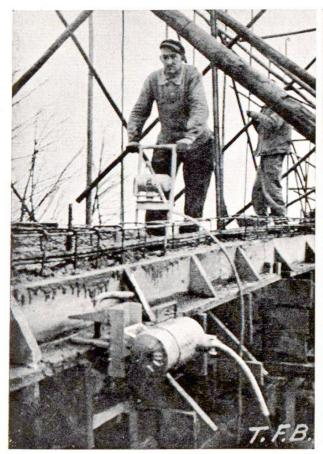
Fig. 2 **Vibration externe** au moyen d'une fourche vibrante et d'un vibrateur électrique fixé sur le coffrage latéral.
