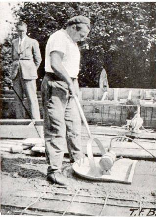
Fig. 3 **Vibration superficielle** au moyen de la pelle vibrante.
