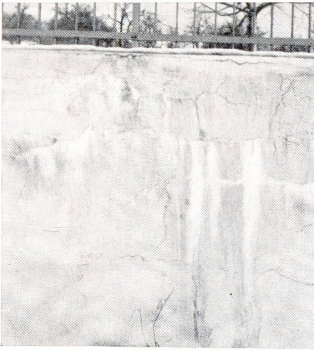
Fig. 2 Efflorescences calcaires sur le crépissage d'un mur de soutènement en béton (traînées blanches partant des fissures de l'enduit).
