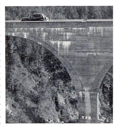
fausses qui règnent à ce Fig. 1 Efflorescences calcaires sur les murs frontaux sujet puisque, les étables d'un pont en béton armé (traînées blanches partant des joints de reprise).
