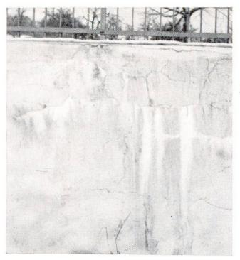
Fig. 2 Efflorescences calcaires sur le crépissage d'un mur de soutènement en béton (traînées blan- 3° Eviter autant que possible ches partant des fissures de l'enduit).
