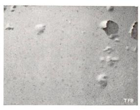
Fig. 2 Boursouflures d'une peinture à l'huile surface de base constituée par un enduit au ciment.
