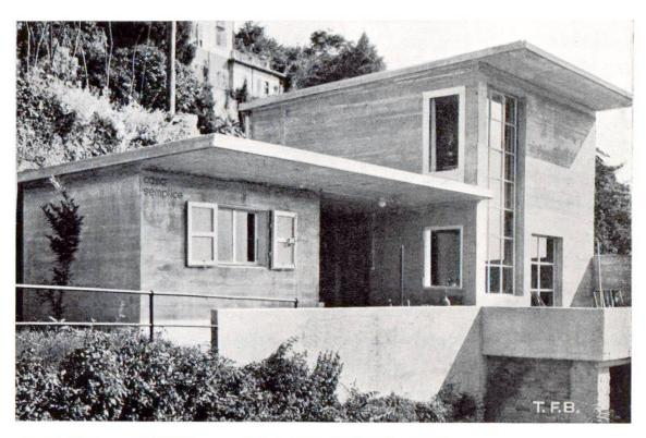
Fig. 3 Maison d'habitation en béton armé, isolé à la chaleur Coefficient de passage thermique des murs extérieurs k=1,0 du toit plat (dalle isocub) k=0.6
