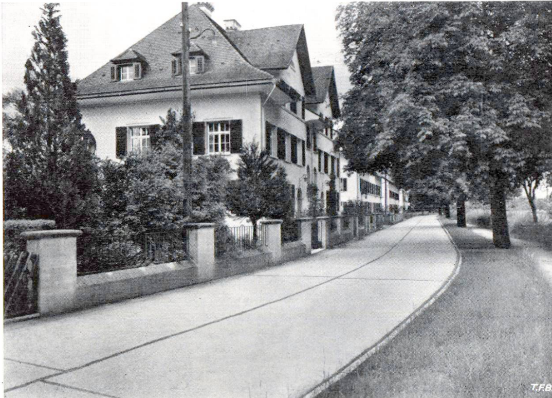
Fig. 3 La rue du canal à Bürklen (Ct. de Thurgovie), construite en 1935; largeur: 5 m Exécution: Georges Oehri, entrepreneur, Bürklen.
