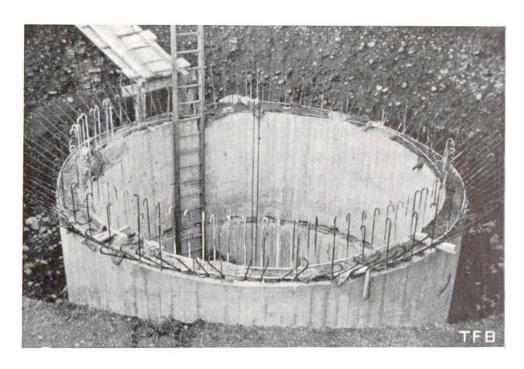
Fig. 2 Construction d'un abri de protection en béton armé Système «Schindler»
