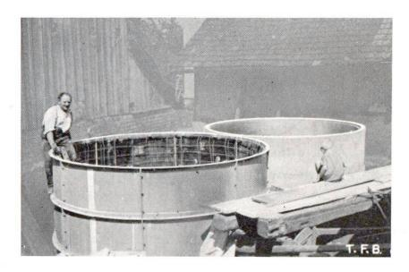
Fig. 4 Construction de 2 silos à fourrage vert en béton armé, à Goldach près de Saint-Gall à gauche: coffrage métallique transportable auquel est suspendue l'armature des parois, à droite: le silo terminé, d'une contenance de 19 m³.
