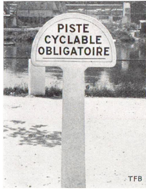
Fig. 4 Signalisation d'une piste cyclable au moyen d'un poteau en béton avec inscription.
