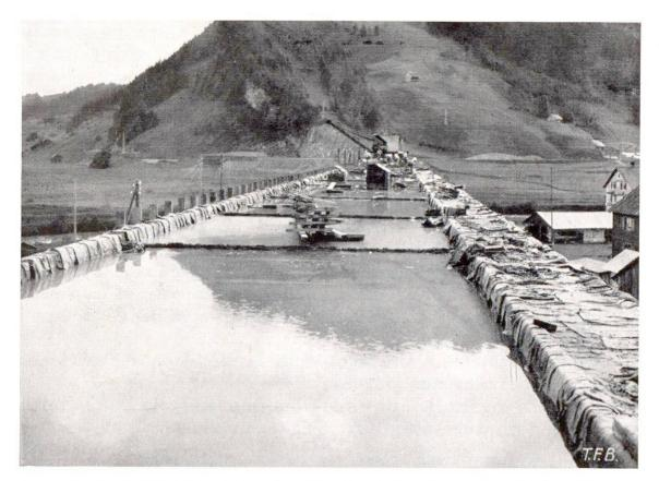
Fig. 3 **Humidification d'un tablier de pont en béton armé.** Inondation du tablier encaissé et recouvrement des consoles surélevées avec des sacs humides. Viaduc de Steinbach des entreprises hydro-électriques de l'Etzel.
