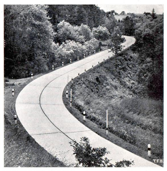
Fig. 3. **Une route moderne en béton.** Tronçon Steckborn-Eichholz (Ct. de Thurgovie). Surface: 18722 m². Construite en 1936.
