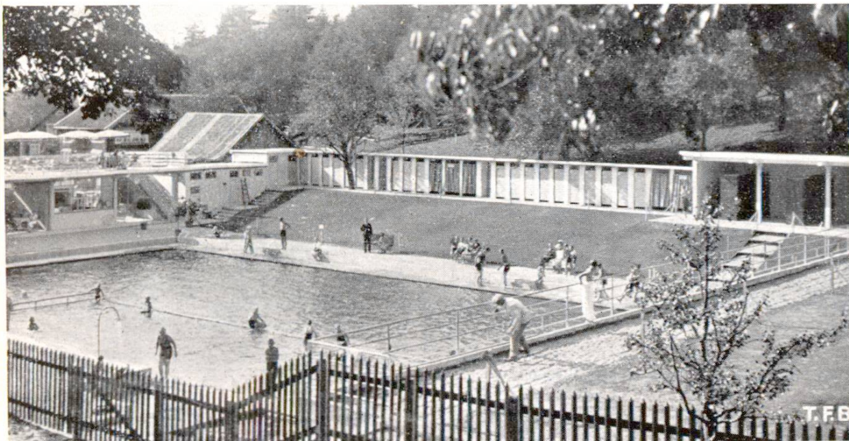
Fig. 3 Piscine de Walzenhausen (Appenzell Rh. ex.). Planchers, parois extérieures et cloisons intermédiaires en ciment-métal déployé. Eléments porteurs et bassin en béton armé. Projet et direction des travaux: Bureau d'ingénieur Keller, Brugg. Exécution: Bruderer & Calderara, Teufen-Walzenhausen.
