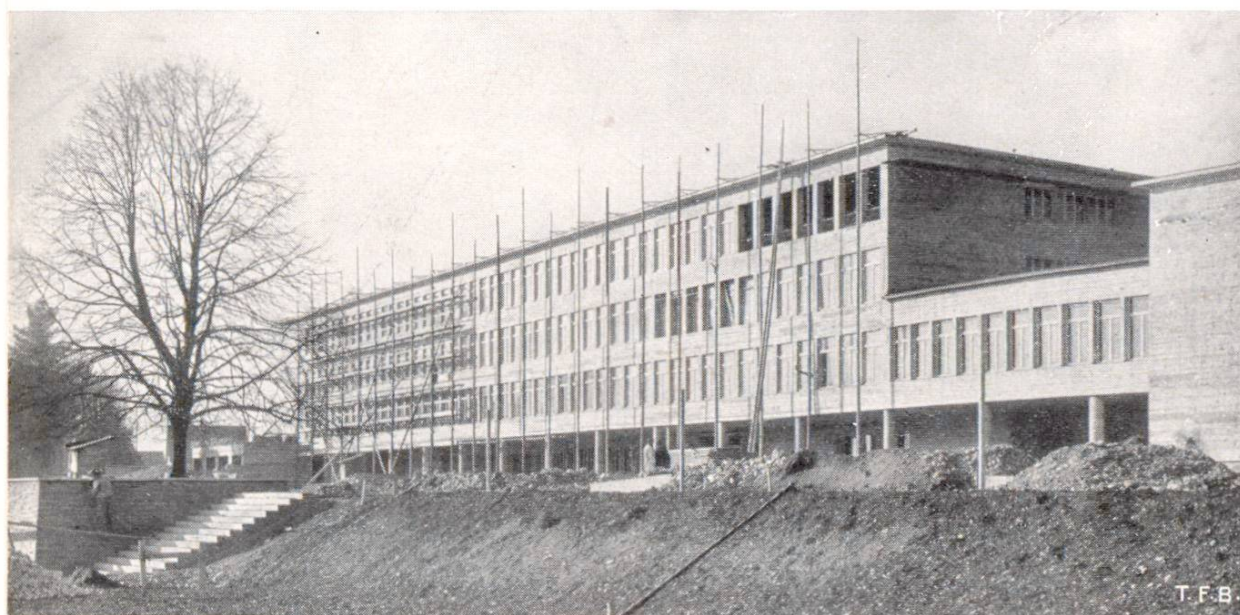
Le nouveau collège de Seebach-Zurich. Toutes les façades sont en béton apparent. Architecte: Dr. R. Rohn, Zurich Entreprise: Locher & Cie. S. A., Zurich
