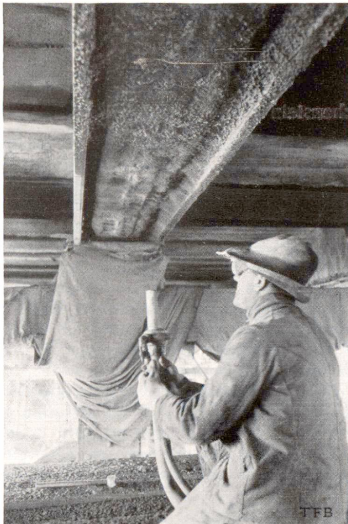
Fig. 3 Gunitage des membrures inférieures
