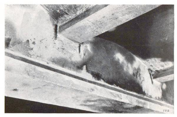
Fig. 4 Entretoises et poutre principale enrobées de gunite
