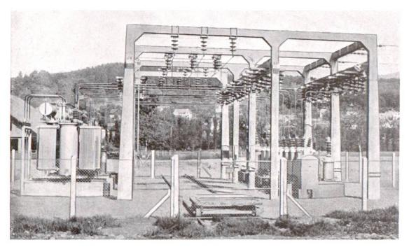
Fig. 5 Station de couplage en plein air des Fabriques de ciment Jura, à Aarau Projet: Fabriques de ciment Jura, Aarau Calcul: H. Scherer, Ingénieur, Lucerne Exécution: Schäfer & Cie., Aarau
