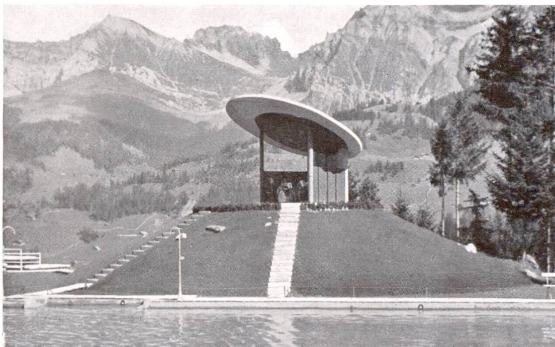
Fig. 1 Kiosque à musique de la piscine d'Adelboden
