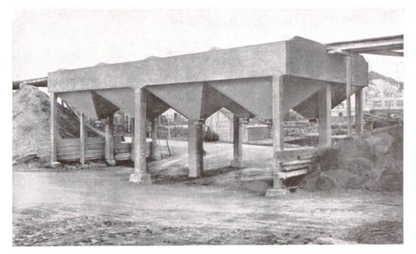
Fig. 4 Silos à gravier de la S.A. Oberhard à Zurich Projet et calcul: E. Rathgeb, Ingénieur, Zurich Exécution: J. J. Weilenmann, Zurich
