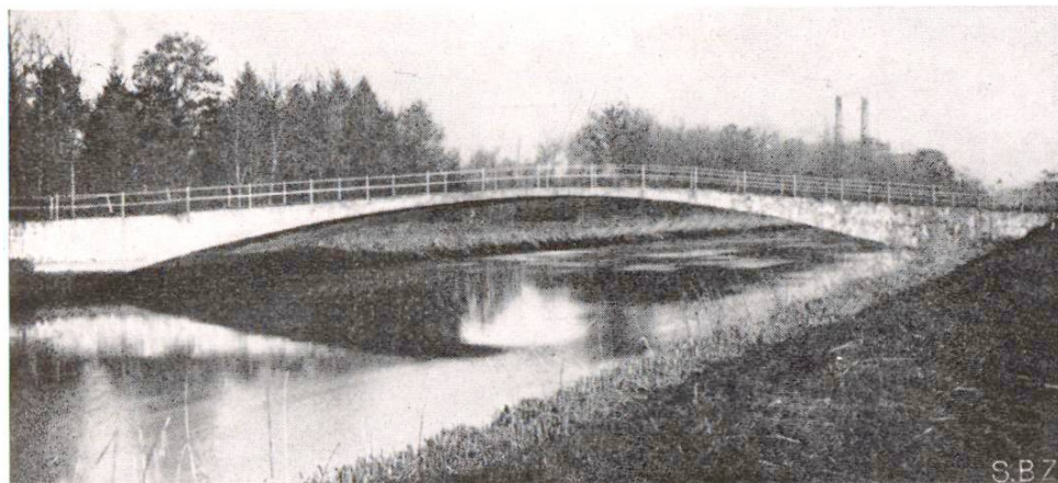
Fig. 1 Pont-route des fabriques de ciment Jura à Wildegg sur le canal de l'Aar
