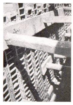
Fig. 6 File de palplanches jusqu'à 12 m. de profondeur, dans les formations crétacées des rives du lac de Constance. (Projet et direction des travaux: F. Bœsch, Ing., Zurich.)
