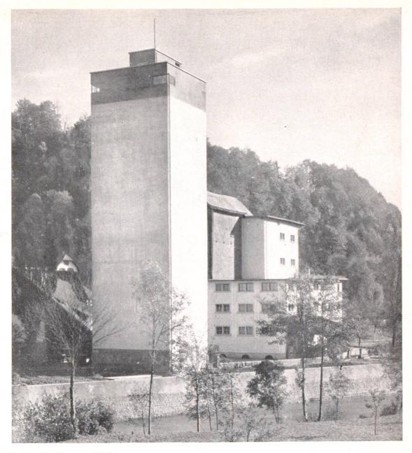
Fig. 3 **Moulins de Wolhusen** Silo en béton armé exécuté au moyen de coffrages glissants Hauteur: 28,5 m.; durée de la construction: 10 jours
