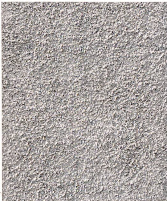
Enduit bien exécuté (rusticage à la truelle)
