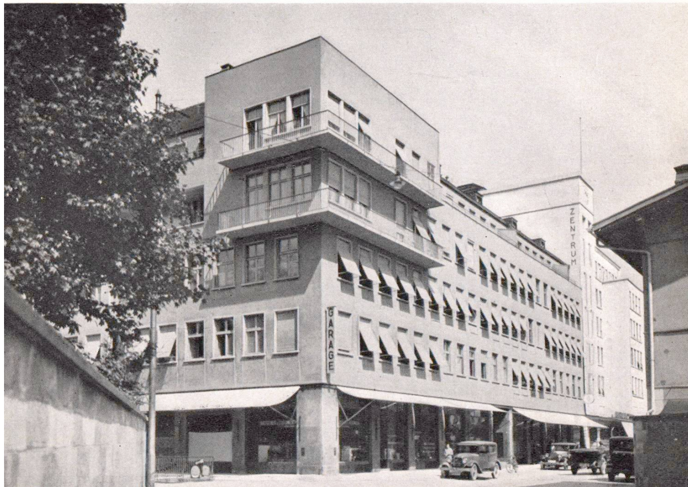
Bâtiment d'affaires «Testa», Zurich (Entreprise Ed. Zublin & Cie. S.A., Zurich) Façades enduites complètement d'un mortier de chaux hydraulique
