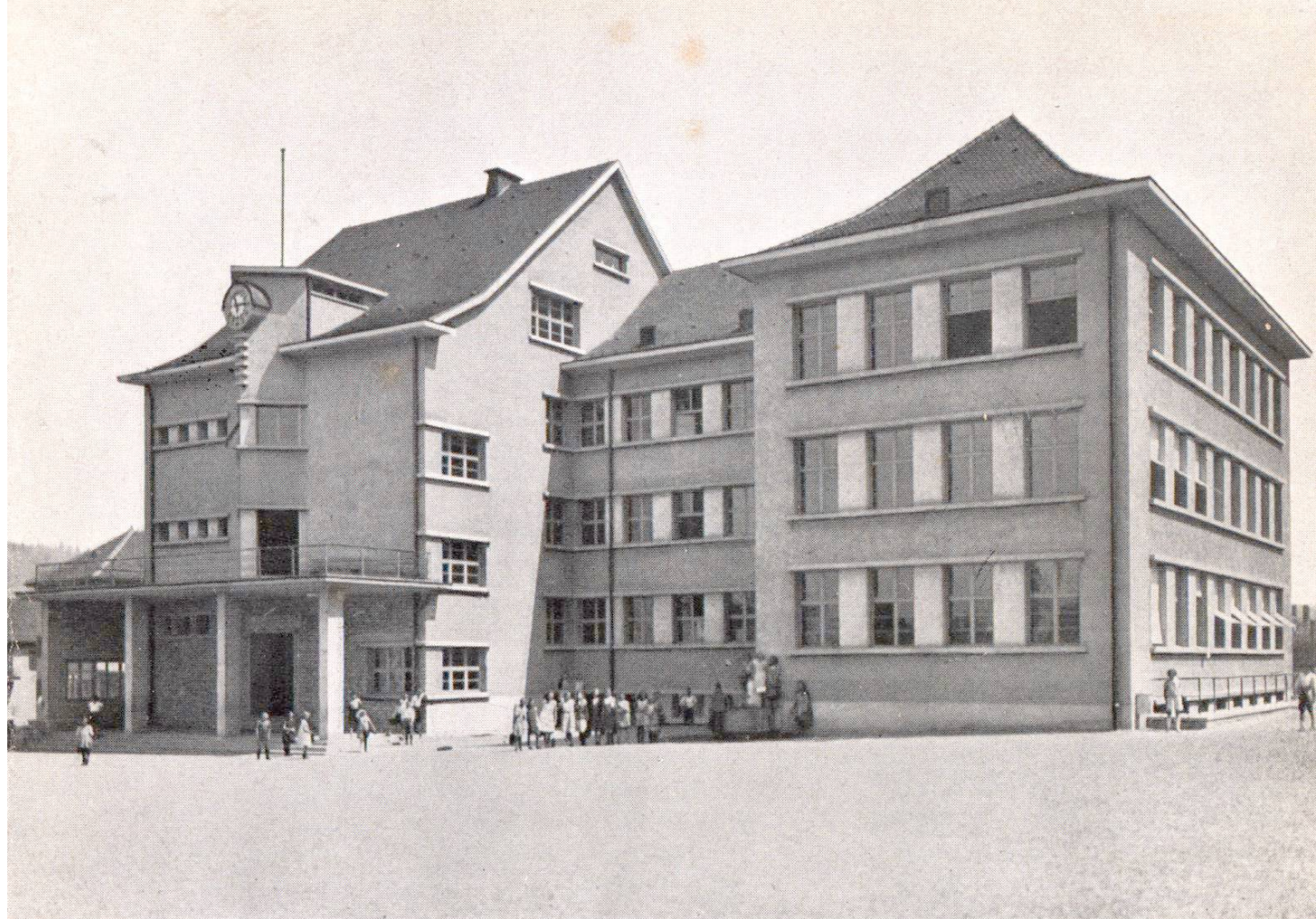
Bâtiment scolaire à Schlieren (Entreprise Ed. Zublin & Cie. S. A., Zurich) Enduits de façade à la chaux hydraulique
