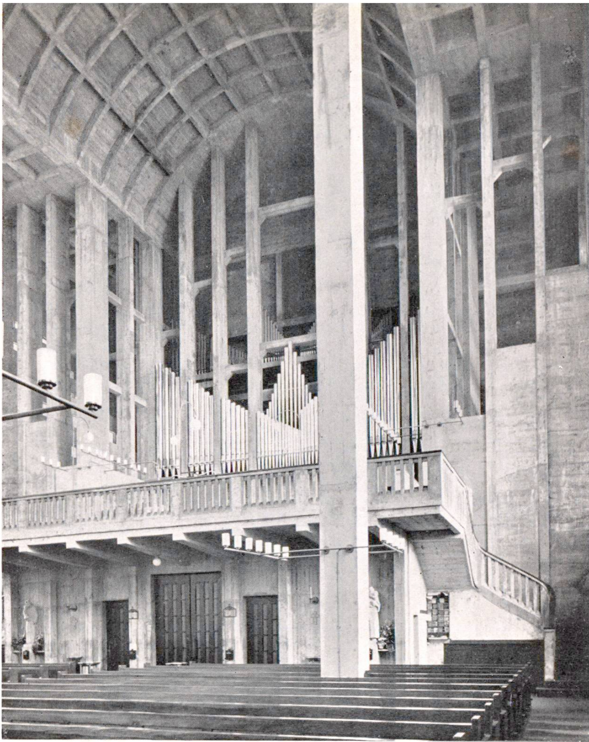
Eglise de St-Antoine à Bâle. Architecte: Prof. K. Moser, Zurich Entreprise: Ed. Zublin & Co. S. A., Bâle
