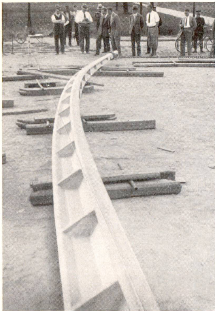
Fig. 2. Essai de charge d'un mât en béton armé système Kisse — à remarquer la flèche considérable
