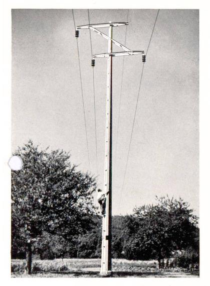
Fig. 1. Ascension d'un mât en béton armé, système Kisse — Ligne à haute-tension Wettingen-Zurich
