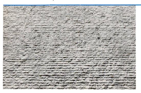
Photographie de la surface d'une route en béton montrant que, grâce à notre procédé spécial, la surface, tout en étant plane, reste rugueuse: cela assure une parfaite adhérence des roues en évitant les embardées la nuit, les obstacles se détachent très visiblement de la surface claire de la route.
