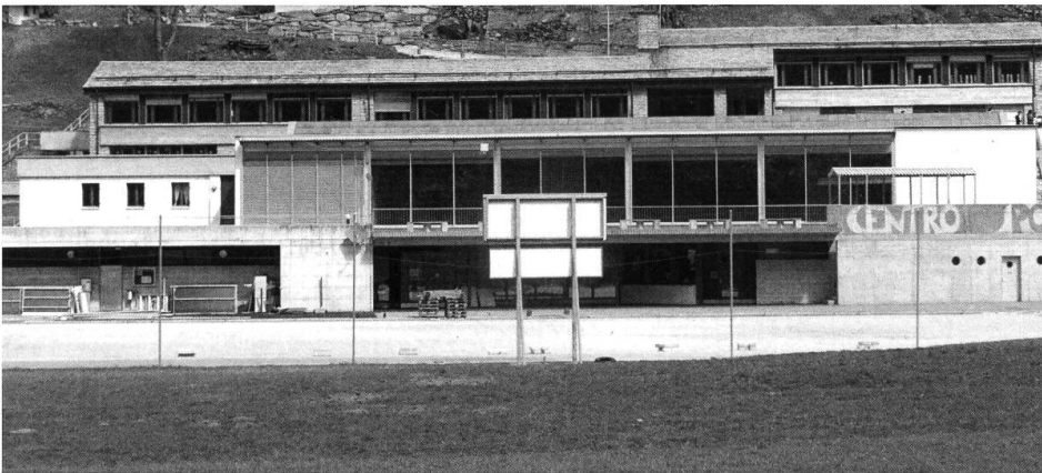
Schulhaus Vicosoprano-San Cassiano mit neuer Mehrzweckhalle (Foto: Prisca Roth)
