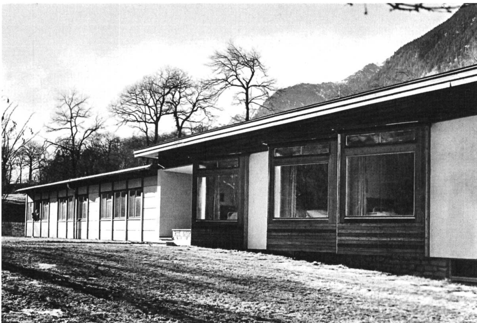
Erweiterungsbau Spital Flin der Gemeinde Soglio mit Provisorium in Durisolbauweise (links), Südansicht, Aufnahme vom 26.2.1959 (Archiv EWZ)
