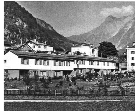
EWZ-Wohnsiedlung in Vicosoprano, Südansicht der unteren Hauszeile mit drei 4-Zimmer- und zwei 5-Zimmerwohnungen, Typ B und A, Aufnahme vom 15.9.1958 (Archiv EWZ)
