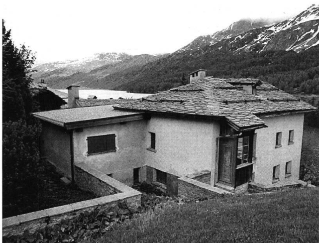
Verbindungsbau mit Flachdach zwischen dem Wohnhaus und dem Heustall in Maloja Capolago aus dem Jahre 1930, Zustand 2008 (Foto: Roland Frischknecht).
