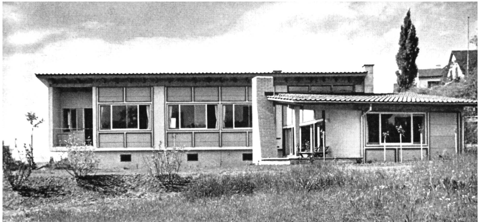
Durisol-Wohnhaus, Zürich, Südostansicht, 1950 (Werk 7:1951, S.193)
