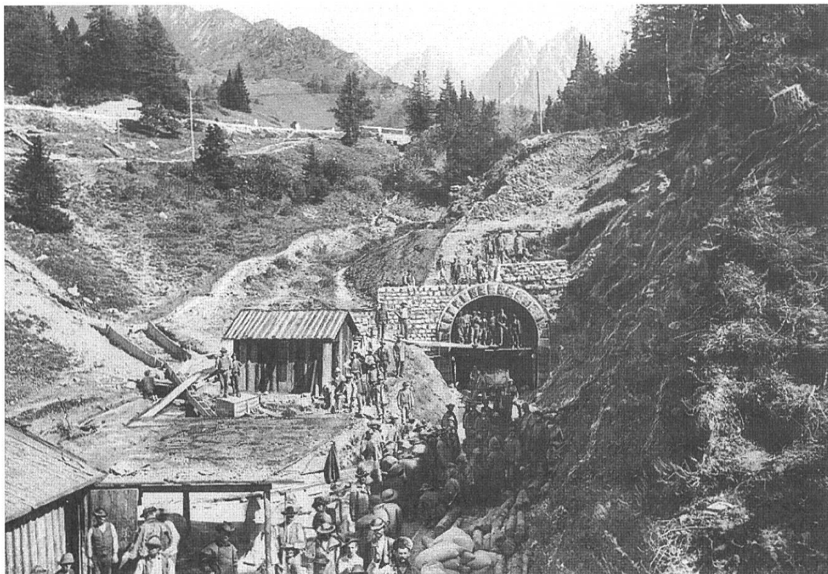
Die im Bau befindliche Nordeinfahrt des 1903 eröffneten Albula-Bahntunnels (Archiv Engadin Press AG, Samedan).
