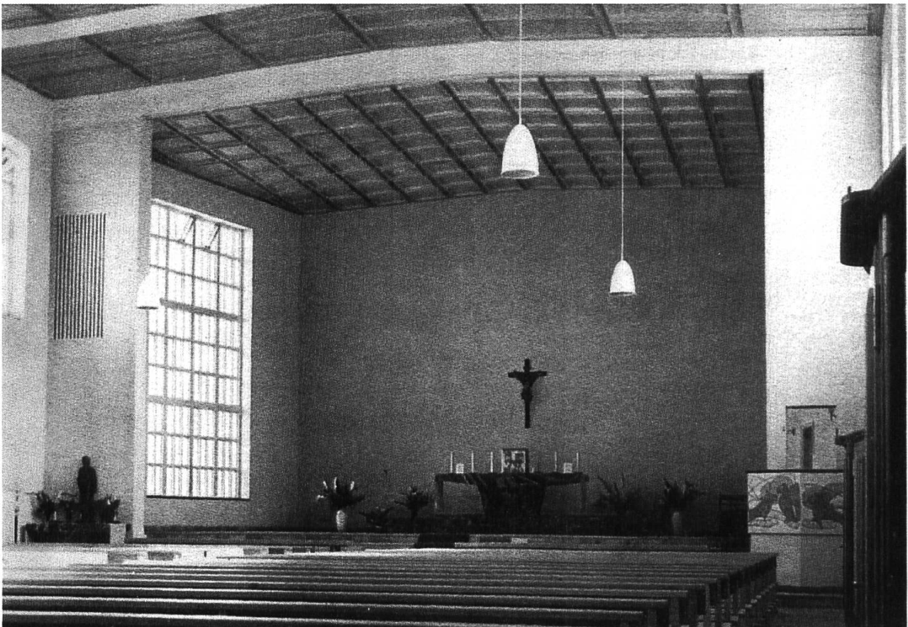
Bild 2: Inneres der neuerbauten Kirche mit Blick gegen den Hauptaltar 1956 (Archiv der römisch-katholischen Kirche Gelterkinden).
