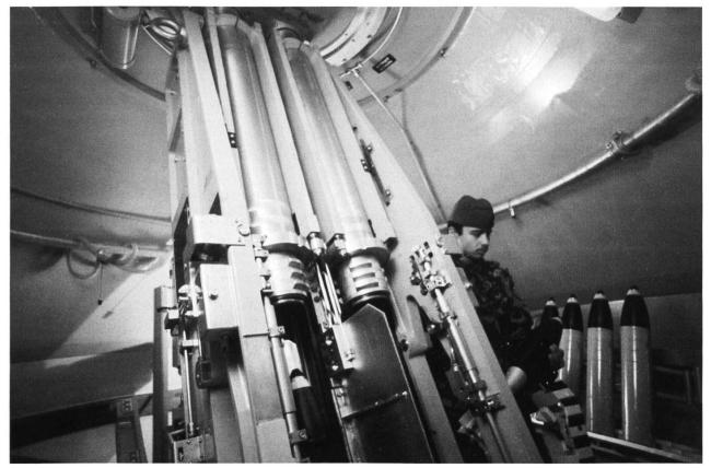
**Abb. 21abc:** Der als Weidstall getarnte unterirdisch-zweistöckige Festungsminenwerfer bei Oltingen. 1. UG = Geschützraum, 2. UG: Aufenthalts- und Serviceraum für 20 Mann, Richtraum, Munitionsmagazin. Über dem heute sichtbaren Panzerdeckel zu den Rohrmündungen befand sich früher allerdings ein Kompostbehälter! (Bilder: Josua Oehler, Arboldswil/VBS Bern)
