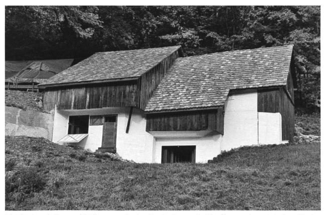
**Bild 19:** Der als Tenn und Stall getarnte Bunker Ost der Sperrstelle Diepflingen, erbaut ab Anfang Oktober 1938 bis Juli 1940. Linke Öffnung für die Panzerabwehrkanone, rechte Öffnung für das Maschinengewehr. Umrüstung auf 9 cm Pak 50/57 im Jahre 1965. 1984 Demontage der Bewaffnung und Ausserdienststellung. Seit 2017 renoviert, Wiedereinrichtung der militärischen Infrastruktur und betrieben durch den Bunkerverein Diepflingen. (Bild: Bkr Verein Diepflingen)
