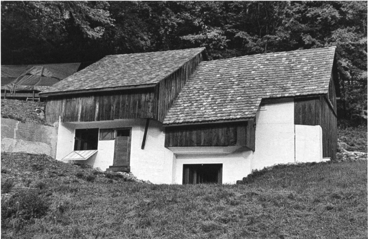
Bild 19: Der als Tenn und Stall getarnte Bunker Ost der Sperrstelle Diepfingen, erbaut ab Anfang Oktober 1938 bis Juli 1940. Linke Öffnung für die Panzerabwehrkanone, rechte Öffnung für das Maschinengewehr. Umrüstung auf 9 cm Pak 50/57 im Jahre 1965. 1984 Demontage der Bewaffnung und Ausserdienststellung. Seit 2017 renoviert, Wiedereinrichtung der militärischen Infrastruktur und betrieben durch den Bunkerverein Diepfingen. (Bild: Bkr Verein Diepfingen)
