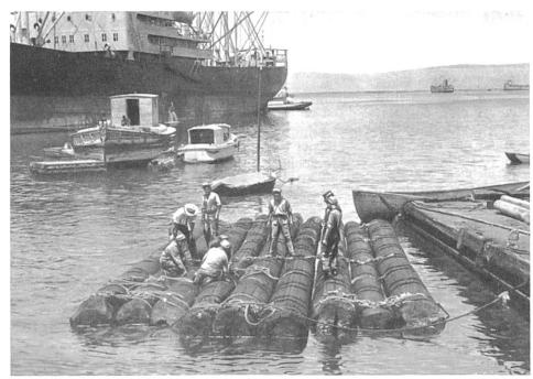
Bild 7: Sicht 1947 auf die zusammengefügten Balsastämme von «Kon-Tiki» während des Zusammenbaus in Peru (Repro aus: Heyerdahl, 1949).
