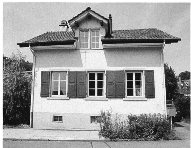
Abb. 5: Dübli's Unterkunft im 1. Stock im Uunderdorf 20 in Arboldswil. (Foto: Josua Oehler, Arboldswil).
