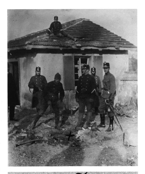
Bild 4.1 und 4.2: Foto der Einschlagstelle und handschriftlicher Vermerk auf der Rückseite der Aufnahme: Muttenz, 6. Dezember 1917. Totenhaus auf Gottesacker, von eingeschlagener Bombe (sic) +. Fenster u. Dach beschädigt. Oeffnung 60 cm tief u. 60 cm Durchmesser. Foto STABL\_NA\_2002\_G\_1\_5\_Bombenabwurf\_Muttenz1
