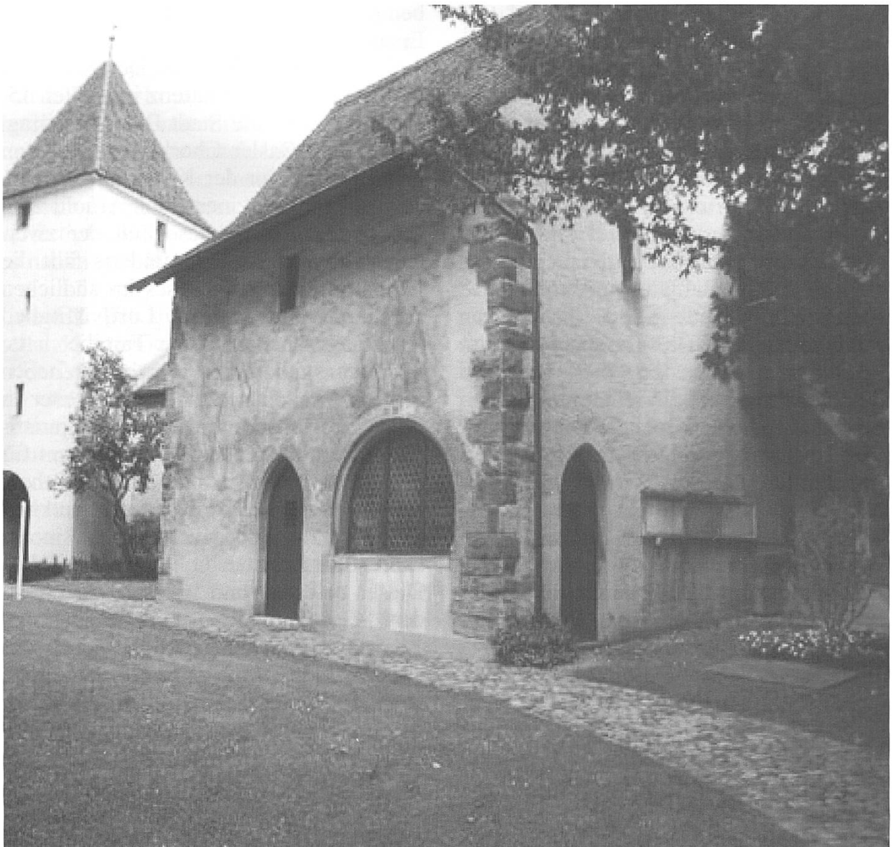
Abb. 1: MuttENZ, Beinhauskapelle der St. Arbogast-Kirche in MuttENZ, Nordwestansicht, zweite Hälfte 15. Jahrhundert.
