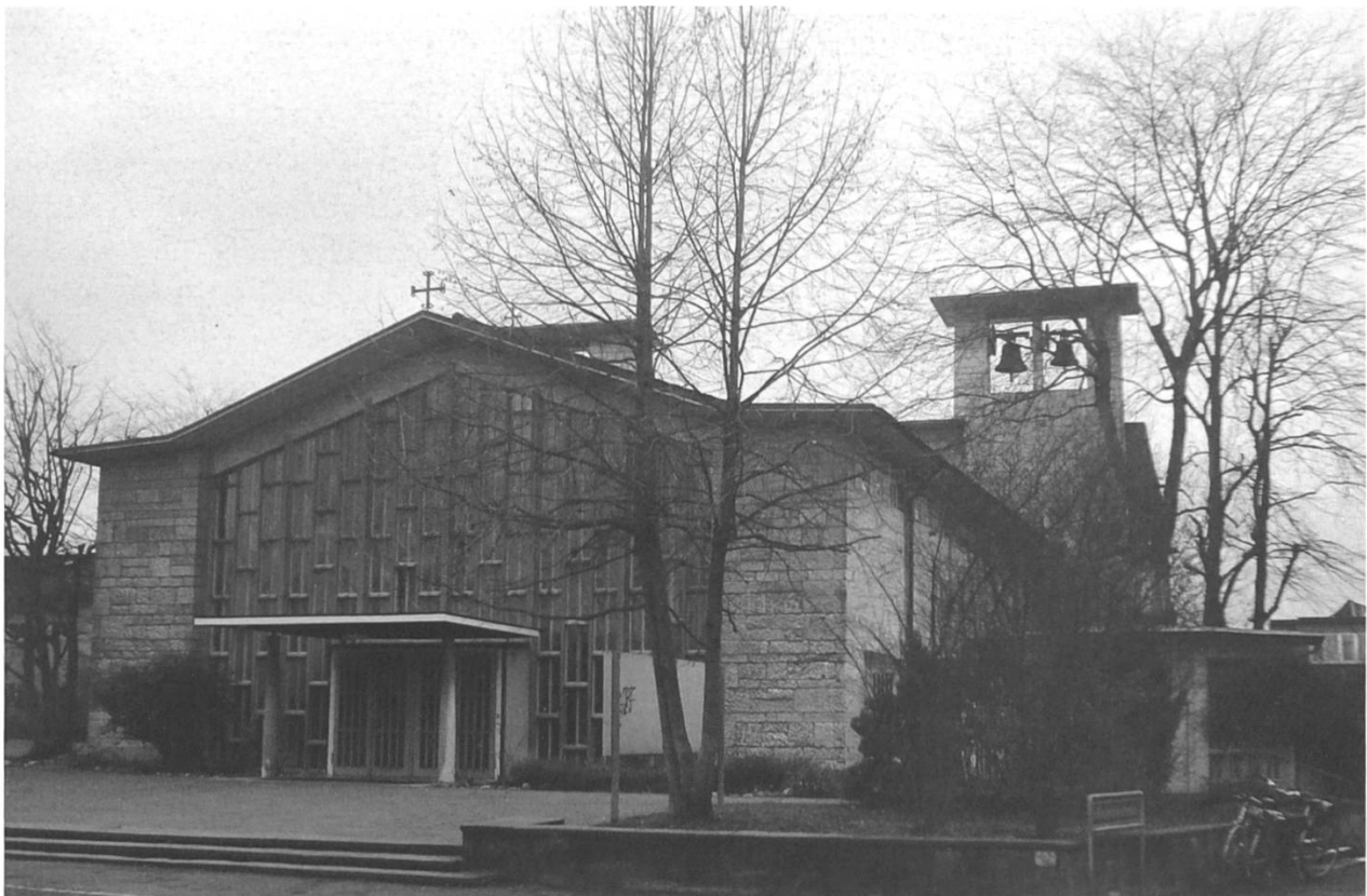
Abb. 1: Die röm.-kath. St. Michaelskirche an der Ecke Allmendstrasse / Kleinriehenstrasse (Hirzbrunnenquartier), erbaut 1948-1950; Architekt: Hermann Baur. (Foto: Dominik Wunderlin)
