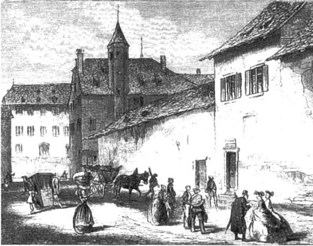
Basel: das «falsche» Geburtshaus an der neuen Vorstadt, über der Türe rechts die Gedenktafel, die 1928 an den Totentanz 2 transferiert wurde. Holzstich nach Zeichnung von August Beck, 1861.
