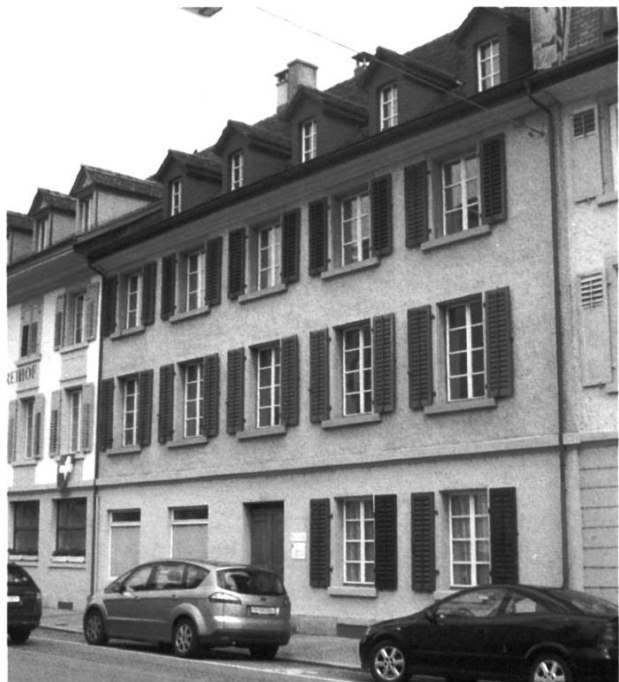
Aarau: Das Verlagsgebäude von Sauerländer (zwischen 1807 und 1834) an der Laurenzenvorstadt 61, wo auch Hebels Gedichtband verlegt wurde. Der spätere (und noch heutige) Verlagssitz wurde 1834 weiter stadtauswärts bezogen. (Foto: Dominik Wunderlin)
