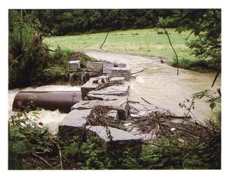
Abb. 5.6: Beim Hochwasser vom 15. Juni 2007 leitet der Damm das überschüssige Wasser über die Uferböschung. (Foto: Steinmetz- und Bildhauerverband Nordwestschweiz)
