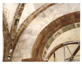
Abb. 1.2: Muttenz, St. Arbogast. Die Gewölbeflächen des Vorchores sind gereinigt. Deutliche Differenzen werden retuschiert. (Foto: Stefan Buess, Restaurator, Gelterkinden)
