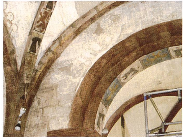
Abb. 1.2: MuttENZ, St. Arbogast. Die Gewölbeflächen des Vorchores sind gereinigt. Deutliche Differenzen werden retuschiert. (Foto: Stefan Buess, Restaurator, Gelterkinden)
