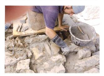
Abb. 5.11: Ausfugen und Auffüllen mit kleinen Steinen.
