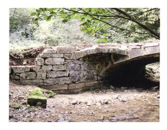
Abb. 5.2: Der bergseitige Seitenbogen vor der Sanierung.
