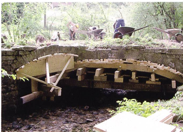
Abb. 5.7: Ein Gerüst stützt von Arbeitsbeginn an den Brückenbogen.
