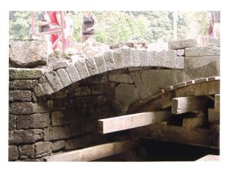
Abb. 5.9: Der talseitige Seitenbogen nach dem Wiederaufbau.
