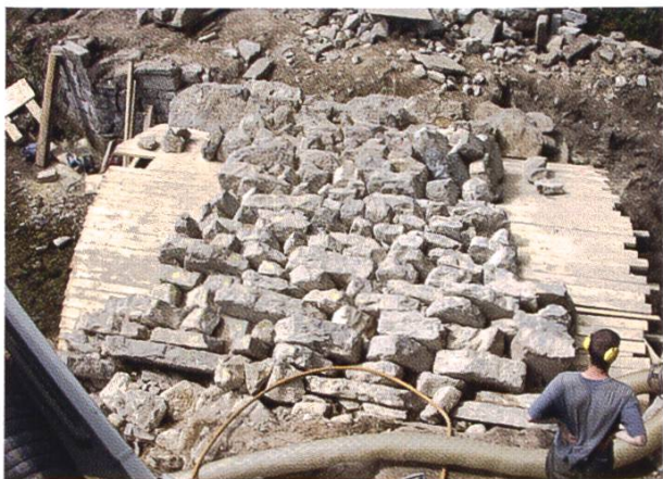
Abb. 5.10: Die Steine werden auf dem Leergerüst neu positioniert.
