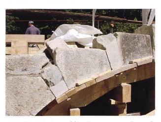
Abb. 5.8: Die bergseitige Bogenaussenseite nach dem Wiederaufbau. Die drei im Bild sichtbaren Läufersteine mussten ersetzt werden, da die alten Steine zerdrückt waren.
