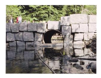
Abb. 5.5: Der Schutzdamm mit dem Durchlass.
