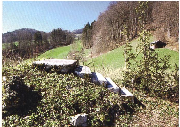
Abb. 7.1: Flühli, ehemaliges Kabinett, Stufen und Podest aus gehauenen Kalkstein. (Foto: Johanna Strübin, November 2007)
