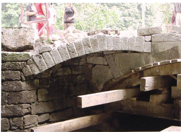
Abb. 5.9: Der talseitige Seitenbogen nach dem Wiederaufbau.
