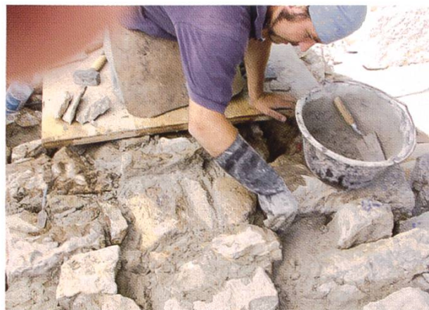
Abb. 5.11: Ausfugen und Auffüllen mit kleinen Steinen.
