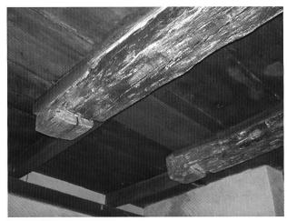
An einen Überzug im Estrich gehängte Balkenlage von 1720 mit Nut für den ehemaligen Mauerbalken.
