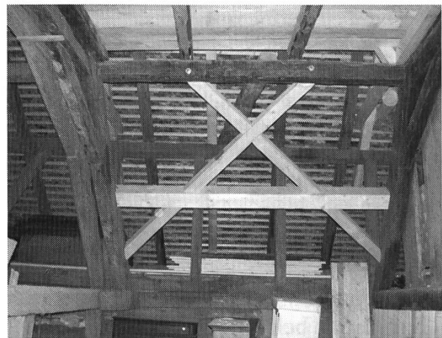
Neue Aussteifung mit Pfettenriegel und Windstreben.
