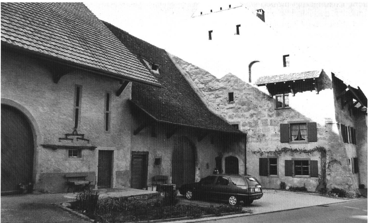
Abb. 24: Blick auf die mächtige Giebelfassade mit der Aufzugsöffnung. Die Fassaden sind mit regelmässigen Tuffsteinquadern gemauert. Links anschliessend das Ökonomiegebäude aus dem Jahre 1678.
