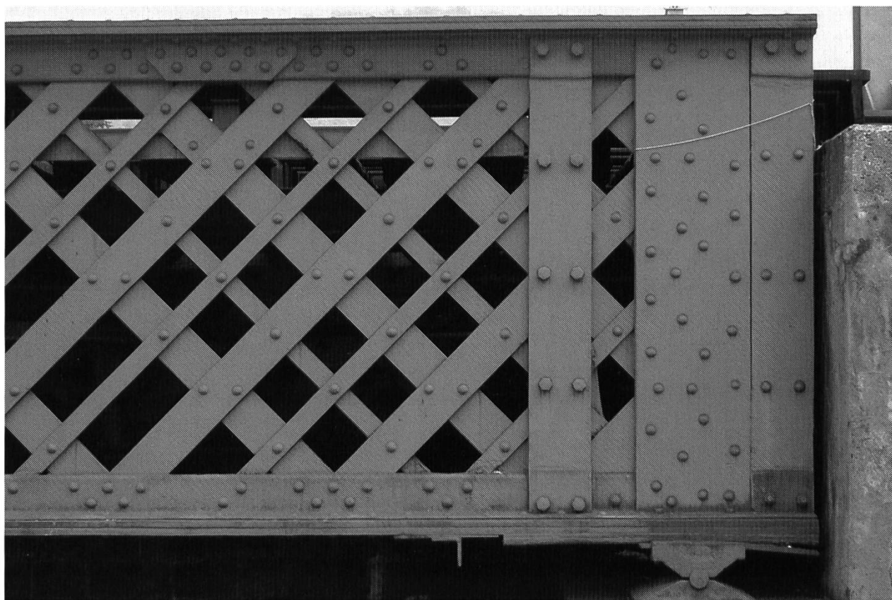
Abb. 31: Ende eines Brückenelementes mit zusätzlichen Diagonalstäben.
