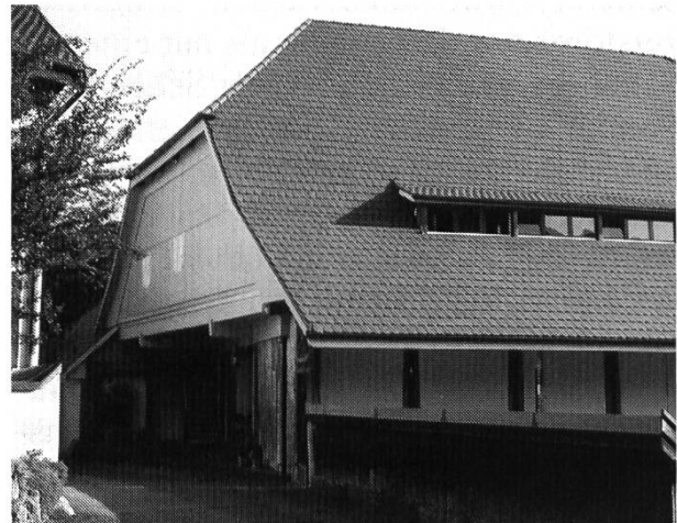
Abb. 4: Loftwohnungen mit Dachaufbau.
