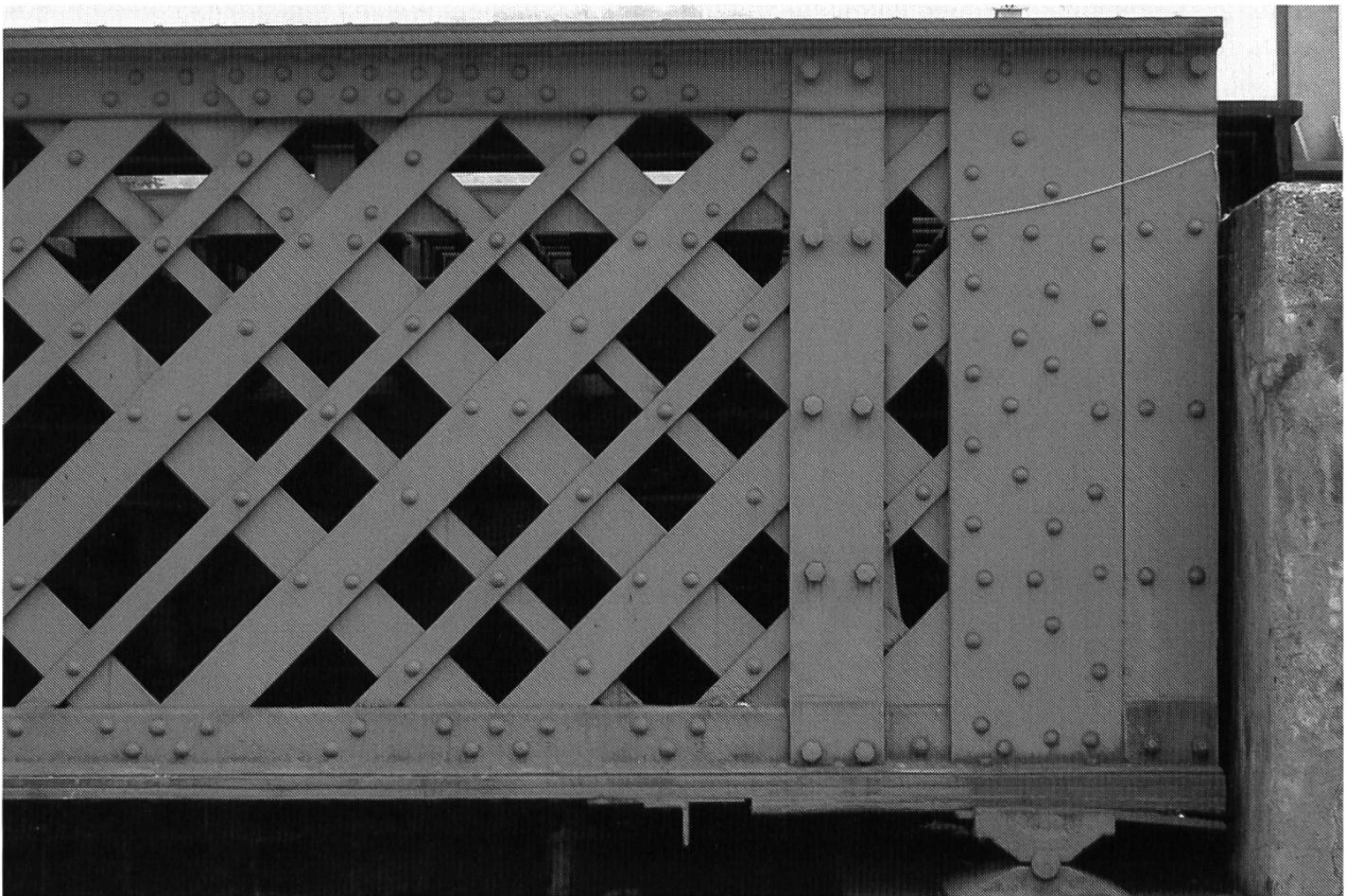
Abb. 31: Ende eines Brückenelementes mit zusätzlichen Diagonalstäben.
