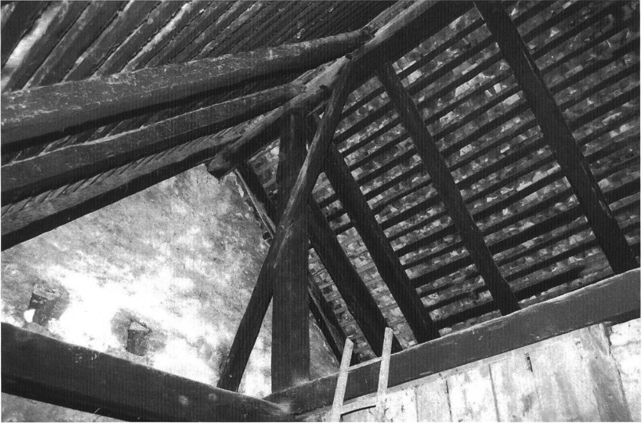
Abb. 25: Blick in den rauchgeschwärzten Dachstuhl. Das Dachgeschoss hat immer noch ein Kaldach und dient als Lagerraum.
