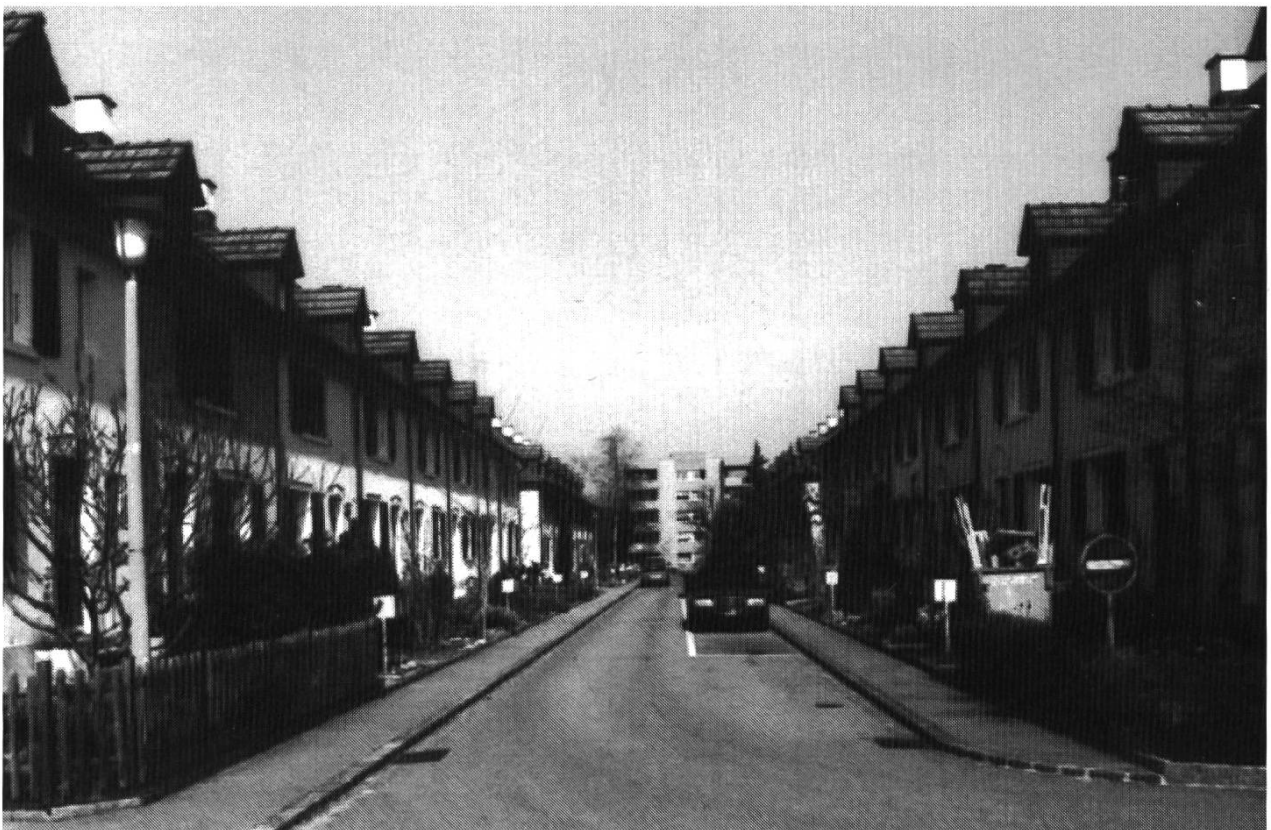
Abb. 40: Siedlung Wasserhaus, Blick nach Norden, 2005.
