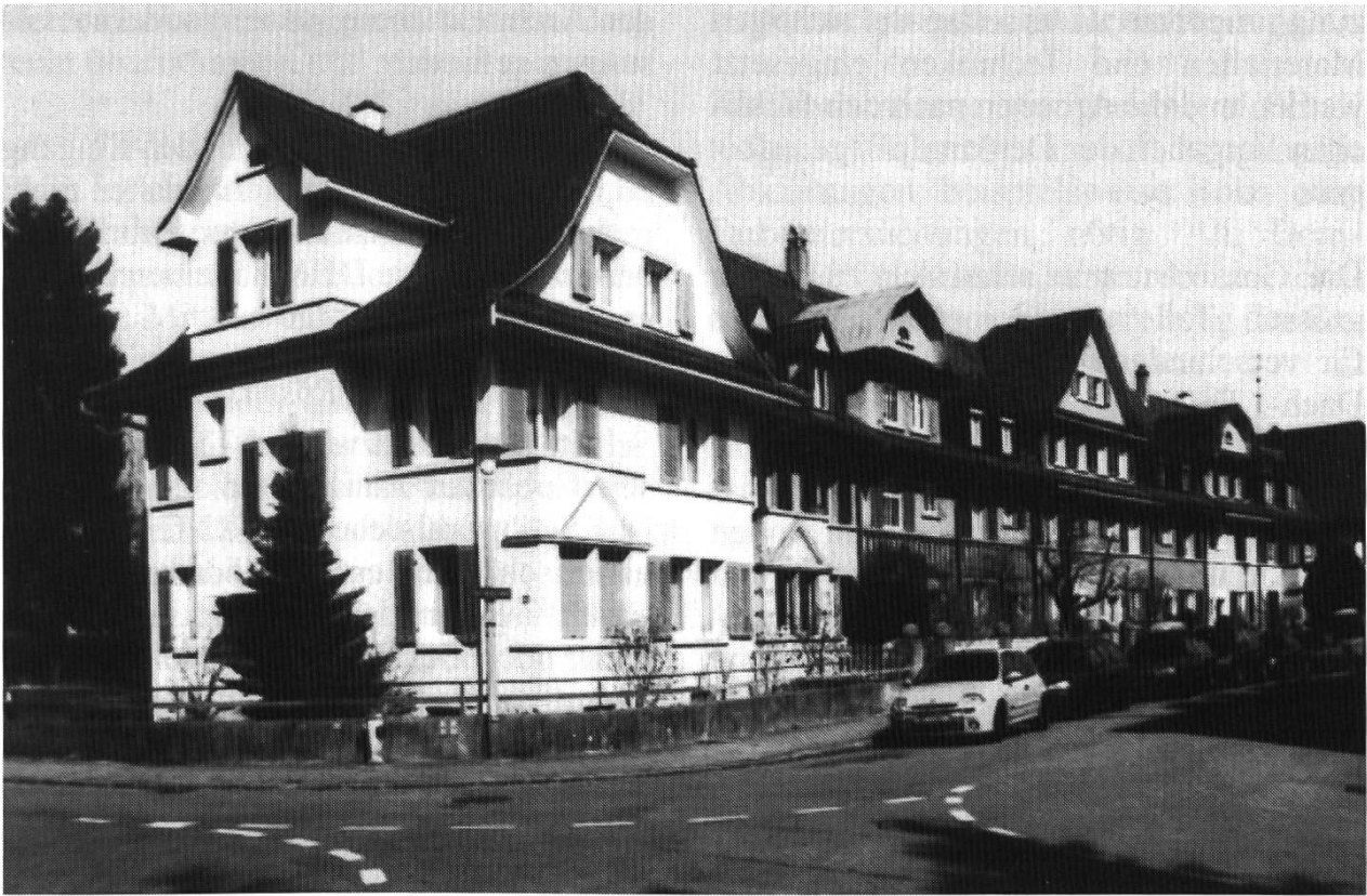
Abb. 45: Siedlung Gartenstadt, Ansicht Südwest, 2005.
