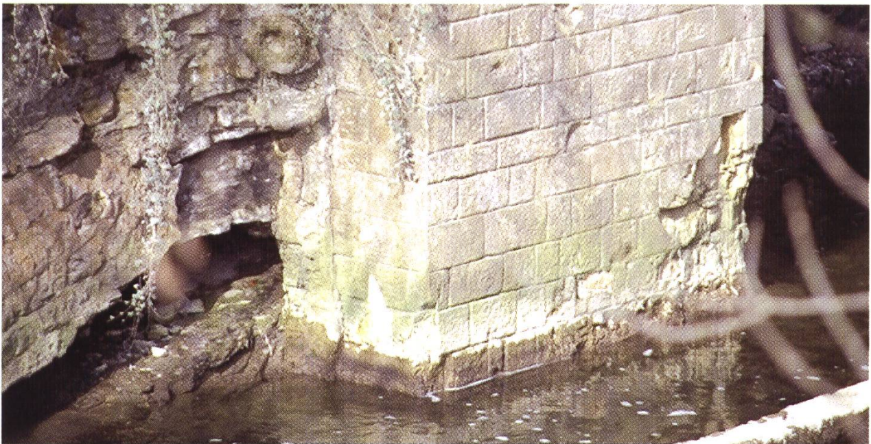
Abb. 13: Die Steinenbrücke ist renovationsbedürftig wie diese Beschädigungen am westlichen Widerlager zeigen. Im Bild links nagen auch durch Wasser verursachte Auskolkungen für einen raschen Zerfall. (Foto ViaStoria, Eneas Domeniconi, März 2003)
