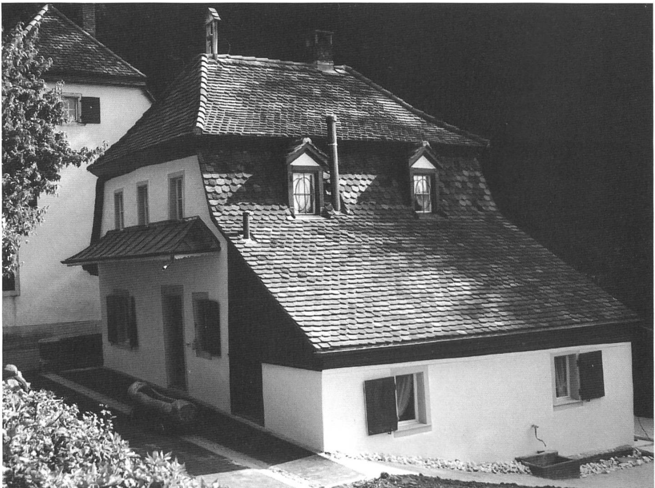
Abb. 7: Arlesheim, Gärtnerhaus der Ermitage, nach der Sanierung.
