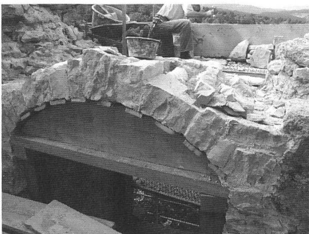
Abb. 5: Arlesheim, Schloss Birseck. Südmauer, der obere Bogenabschluss der Fensteröffnung ist wieder hergestellt.
