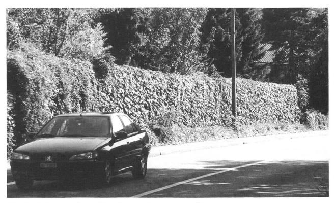
Abb. 19: Muttenz: Bepflanzte Lärmschutzwand mit minimaler Vorzone.
