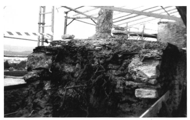
Abb. 4: Arlesheim, Schloss Birseck. Südmauer, Querschnitt Mauerkrone. Die Durchwachsung sowie das ältere Abflusssystem aus Ziegeln sind gut erkennbar.
