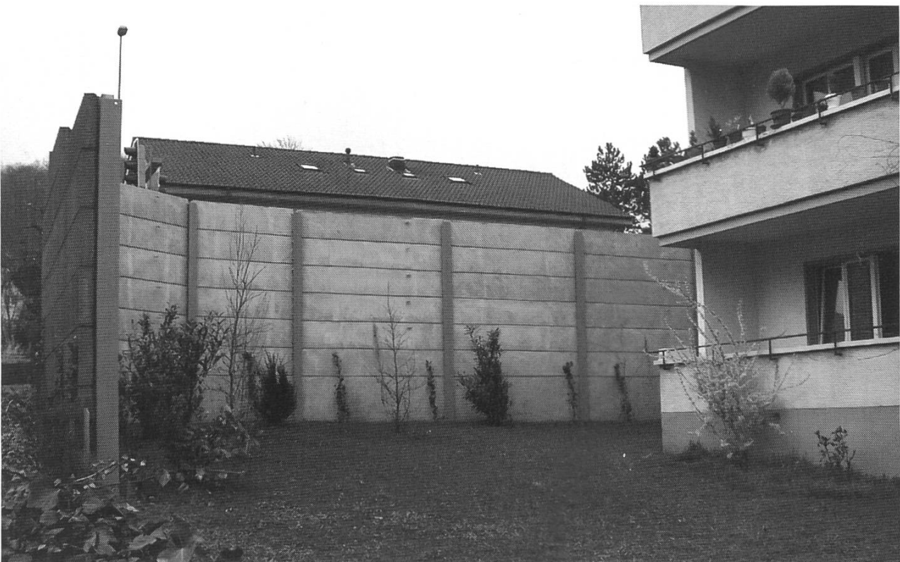
Abb. 18: Bottmingen: Hohe Schutzwand begrenzt Sicht und Grünraum.
