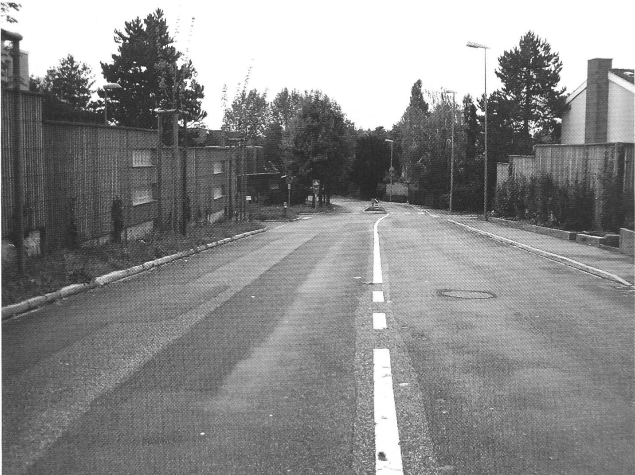
Abb. 14: Bottmingen: Beidseitige Schutzwände engen Sichtfeld ein.
