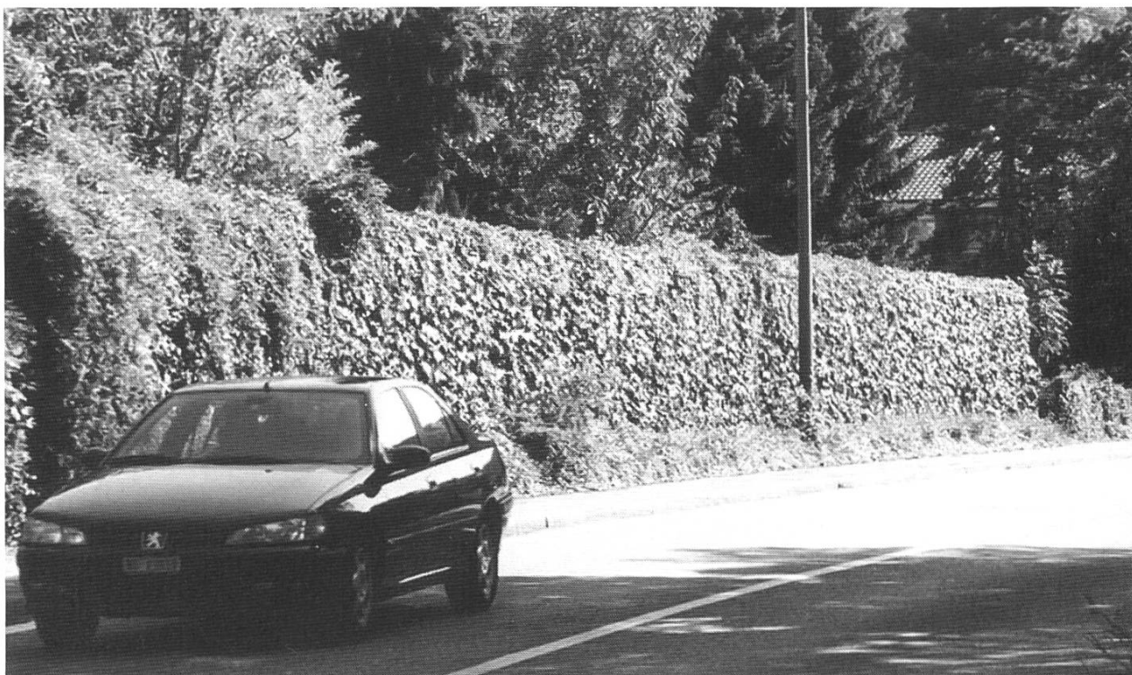
Abb. 19: MuttENZ: Bepflanzte Lärmschutzwand mit minimaler Vorzone.
