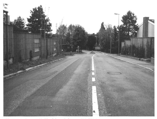
Abb. 14: Bottmingen: Beidseitige Schutzwände engen Sichtfeld ein.
