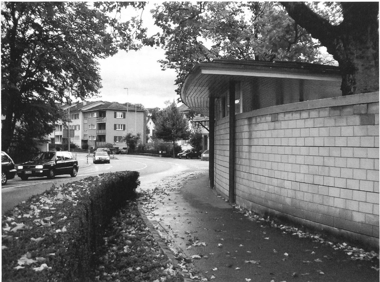
Abb. 15: Therwil: Einheitliche Schutzwand mit Doppelfunktion für Pausenplatz.
