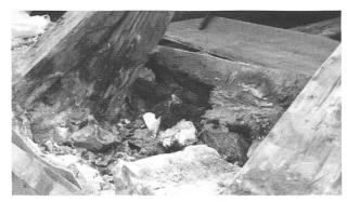
Abb. 1: Laufen, St. Katharinenkirche. Hausschwammbefall auf der Nordseite des Dachstuhls.
