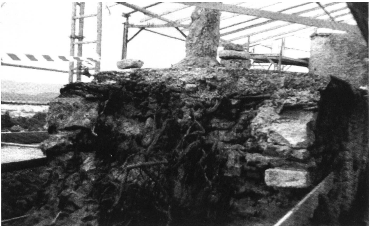
Abb. 4: Arlesheim, Schloss Birseck. Südmauer, Querschnitt Mauerkrone. Die Durchwachsung sowie das ältere Abflusssystem aus Ziegeln sind gut erkennbar.
