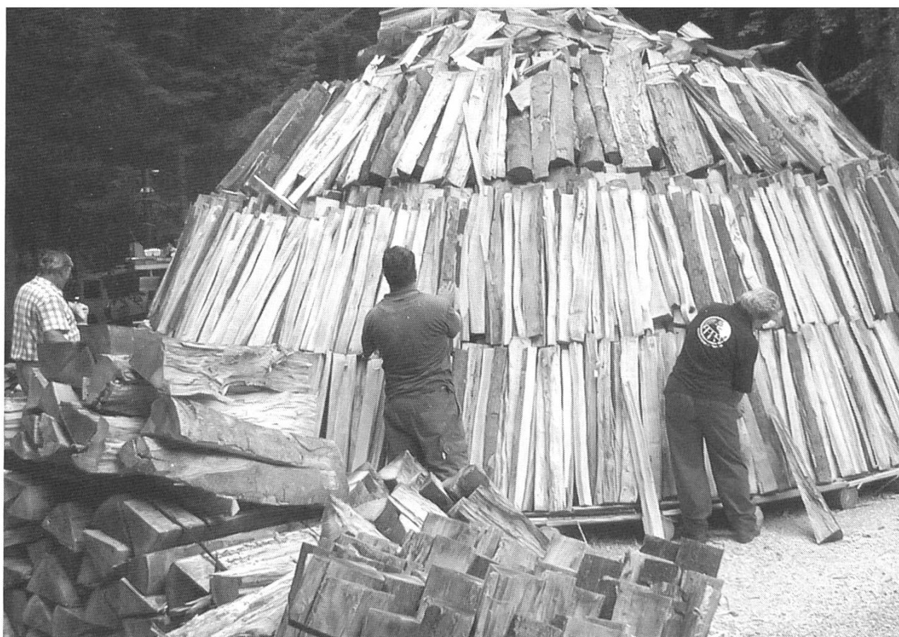
Aufbau eines Meilers in Hofstetten
